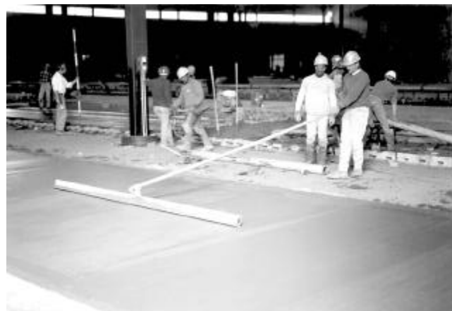
Fig. 8.2.5—“Modified highway” straightedge
