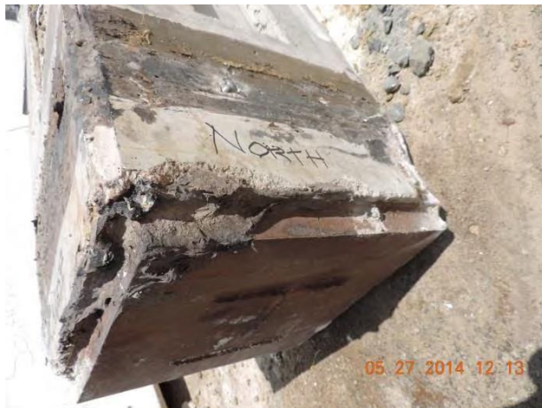
Fig. 84 – W8x40 base plate
